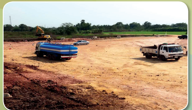
ปรับพื้นถนน และวางท่อรอบพื้นที่ วันที่ 25-31 มกราคม 2561
