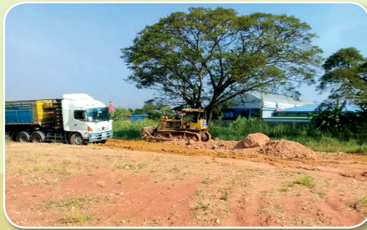
ช่วงถมที่ดิน ครบ 50% วันที่ 18-14 มกราคม 2561
