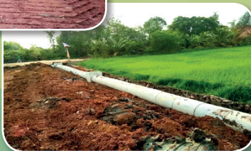
ปรับพื้นถนน และวางท่อรอบพื้นที่ วันที่ 25-31 มกราคม 2561
